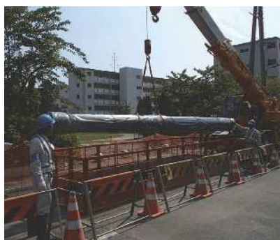
水道管路の取替工事の様子
